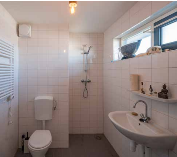
ClimaRad B-Fan in de badkamer: afzuiging op basis van vocht en aanwezigheid.
