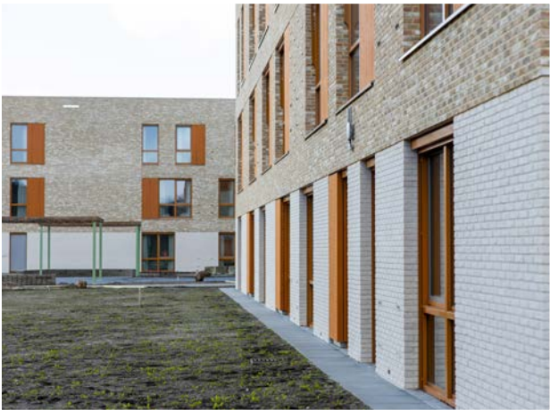
Ingang: het looppad en de kozijnen bestaan uit gerecycled materiaal.
